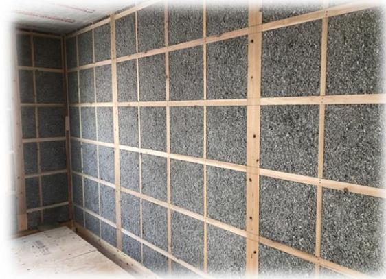
壁内に隙間を作らず、断熱材が吸放出することで、壁体内結露を抑制します！
